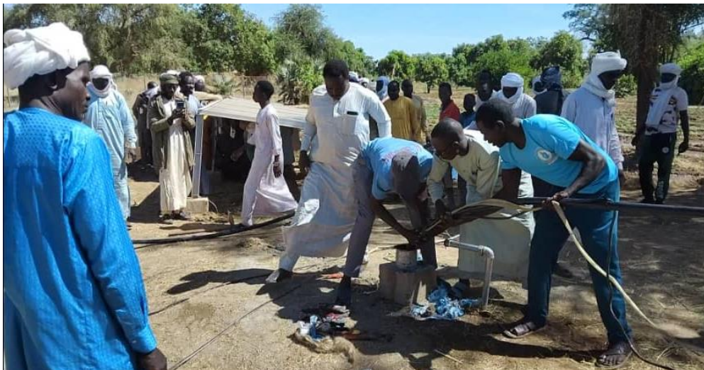
Een half dorp helpt, leert, is betrokken bij de installatie van een pomp en zonnepanelen.
