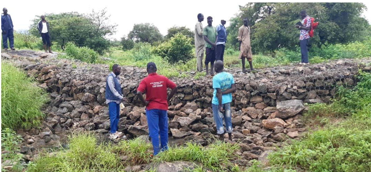
Dam bij Bokyo na het regenseizoen. Zwakke plek kon gerepareerd worden.
