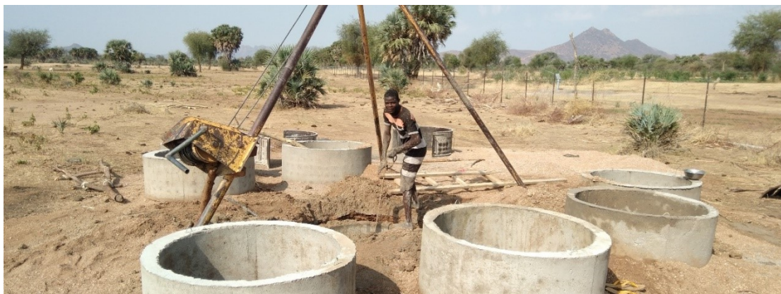
Ringen van cement gaan aan een katrol de put in die vrouwen zelf hebben gegraven.
